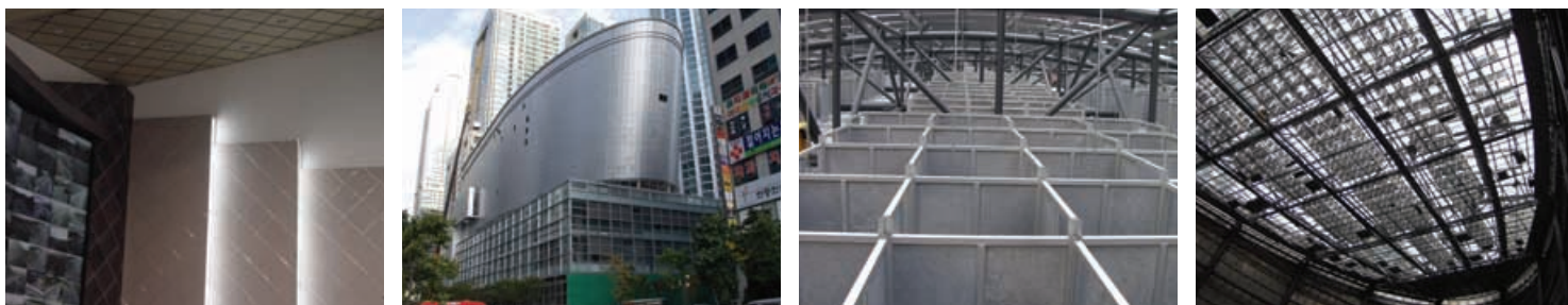
그림 6. 발포 알루미늄 전문 생산업체인 아크로폼텍(주)에서 생산한 흡음재로 시공한 예
