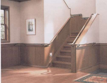
<그림7-40> 복도의 핸드레일을 설치한 예
