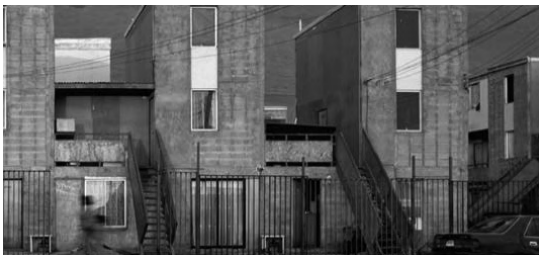
칠레와 멕시코에서 시도되는 증설주택은 현지인들이 자신의 경제적 수준에 맞추어 집을 증축하고 확장할 수 있도록 설계하여 시간이 지나갈수록 자산가치가 증대되도록 설계한 새로운 형태의 사회주택(social housing)이다. (사진 제공: 에딧더월드)
