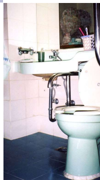
<욕실 바닥 사진> 욕실 바닥 높이를 상향 조정과 더불어 문턱의 단차를 줄인 개조사례
