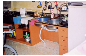
<싱크대> 싱크대 하단 수납문을 제거하고 개방시켜 개조한 사례로 개수대, 파이프 등이 시각상 좋지 않은 사례
