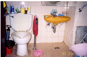
<욕실> 변기 좌측 벽면에 "L"와 우측에 "J"자형 서포트바 설치와 세면기 아래 개방형으로 교체하였으며 샤 워기 레버를 낮추어 사용하고 있 는 사례
