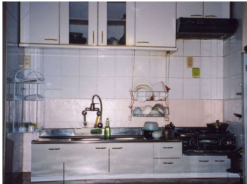
<싱크대> 높이를 39cm로 낮추었고 코부라식 수도꼭지와 가스대 및 가스 콕크 높이를 낮추면서 부엌공간의 자립 생활이 가능하였음.
