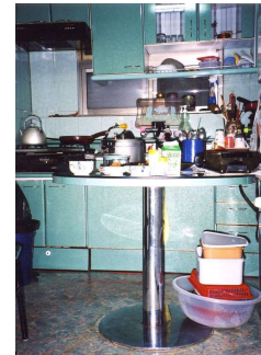
<부엌싱크대> 싱크대 아래 부분을 안으로 움푹 들어가게 개조하여 휠체어 발판이 들어갈 수 있도록 함으로써 조금 더 싱크대 접근이 용이하도록 개조한 사례.
