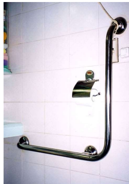
<변기사진> 변기 높이를 사용하고 있는 휠체어 좌판 높이로 낮추고 Support Bar "T", "L"자형을 변기 좌.우편에 설치
