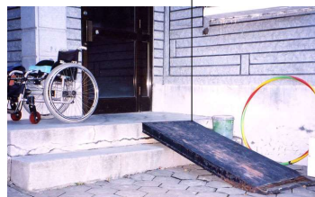
<현관 밖의 경사램프> 2개의 계단이 있는 그 위에 철판으로 간이 경사 램프를(60×150×40cm) 설치한 후 전동휠체어 이용은 가능하 지만 급경사로 일반 휠체어 이용은 어려 움이 있음.
