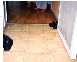
<현관 바닥 사진> 현관 문지방에서 실내 문턱까지 경사지게 바닥을 개조하고 방충망을 설치한 사례
