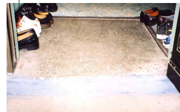
<현관 바닥> 현관 밖의 문턱에서 실내 문턱까지 시멘트로서 경사램프를 설치하여 문턱의 단차를 줄임.
