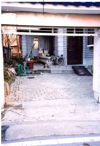
<현관 밖의 경사램프> 2개의 계단이 있는 그 위에 철판으로 간이 경사 램프를(60×150×40cm) 설치한 후 전동휠체어 이용은 가능하 지만 급경사로 일반 휠체어 이용은 어려 움이 있음.
