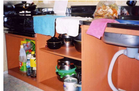
<하단 수납장> 수납장 여닫이 문을 열고 닫을 때 문짝 회전 반경 공간이 넓어 휠체어를 타고 사용하기 불편한 사례
