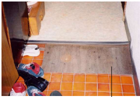
<램프> 현관문턱 단차를 줄이기 위한 간이 나무 경사 램프를 76×31×10cm크기로 설치
