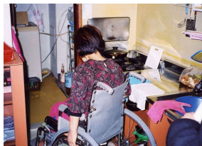
<개선사항> 싱크대 하단부를 개방하여 휠체어 접근이 용이하도록 하였으나 개수대 아래 Bow이 무릎에 닿아 밀착접근이 어렵고 싱크대를 낮추어 가족이 허리를 구부려 사용하는데 불편함.
