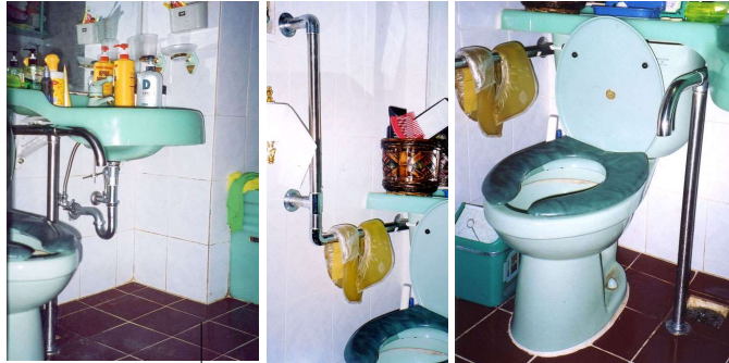
<변기 높이 낮춤 서포트바 설치사진> 변기 높이를 41cm로 낮추고 변기 좌.우편에 서 포트바"L","T"자형을 설치 개조한 사례
