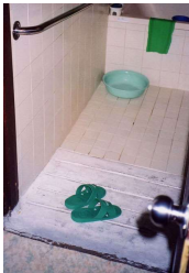
<램프> 욕실 바닥과 문턱 단차를 줄여 휠체어 출입이 가능하도록 경사램프 설치와 이동 가이드 서포트바 설치
