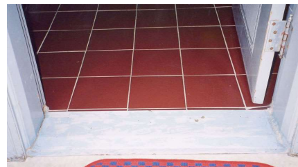
<욕실 바닥 높임 사진> 문턱 단차를 줄여 휠체어 출입이 가능하도록 하 기 위해서 문턱과 비슷한 높이로 욕실 바닥을 개조.
