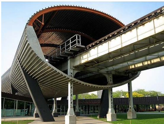
▲ 미국, 시카고 「IIT-MACCORMICK TRIVUNE CAMPUS CENTER」 2003
