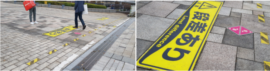
- 바퀴나 굽이 빠지지 않도록 촘촘한 구멍의 배수로와 전방의 장애를 알리는 바닥사인(단차주의)
