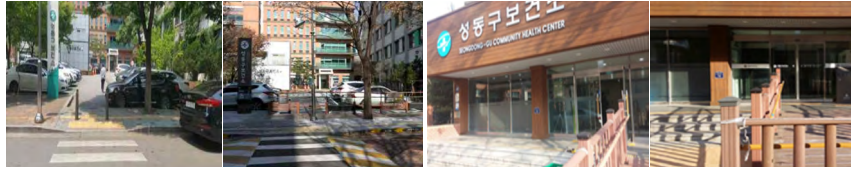
고원식 횡단보도, 보도 평탄화 및 유효폭 확대 등
