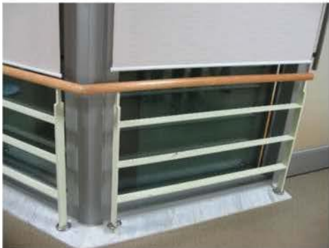
복도 창문을 따라서 설치된 안전손잡이
