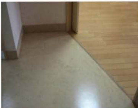
두 가지의 서로 다른 마감재 간에 단차 없이 매끄럽게 시공된 바닥
