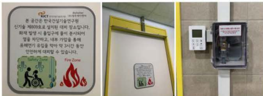
비상시 물이 분사되어 실 안에서 일시적으로 대피가 가능한 장치
