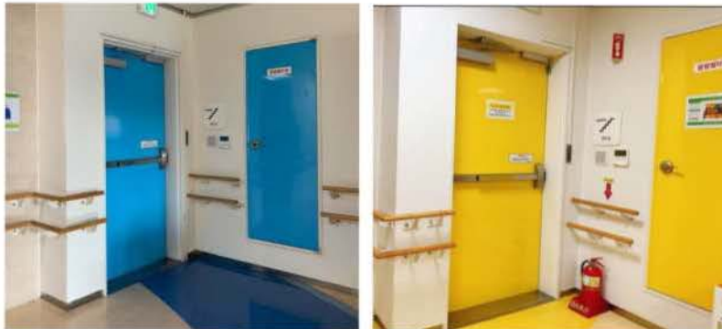
각 층별 색을 출입구와 비상구, 바닥에 적용하여 인지성을 높인 공간
