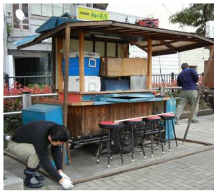
바닥에 외벽선 설치
