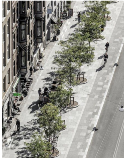
01 무단차 경계연석 설치 및 간결한 보도패턴 적용
