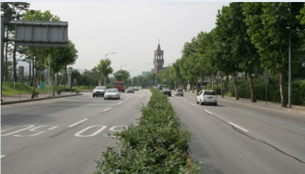
01 운전자의 시야를 방해하지 않는 수목 설치 사례
