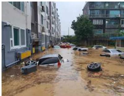
저지대 주택가 침수 (대전 갑천 인근 정림동)
