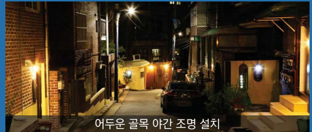
안심·휴식 가능한 안전시설물 설치
