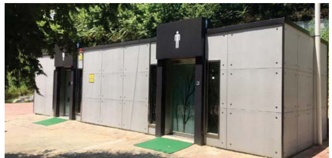
송파구 : 공중화장실 리모델링 사례
