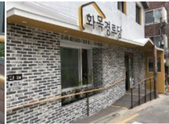
[그림120] 진입로 손잡이 설치
