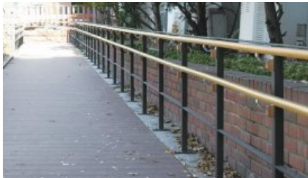
[그림119] 진입로 손잡이 설치
