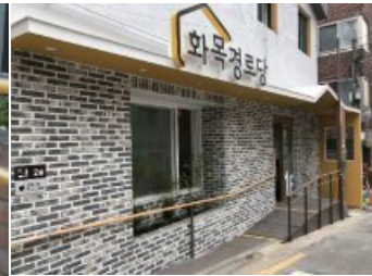
[그림179] 진입로 손잡이 설치
