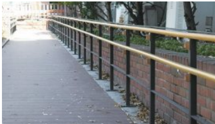
[그림178] 진입로 손잡이 설치
