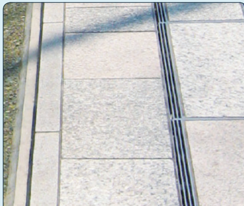
간격이 좁고 바닥감재와 높이가 동일한 배수로 덮개 설치
