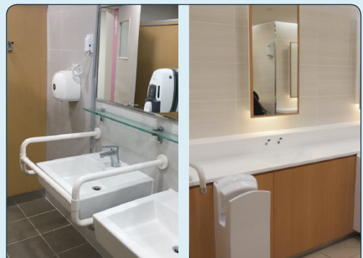
세면대 이용편의를 위해 수평손잡이를 설치하고 소지품 선반과 가방걸이 등 설치
