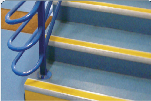
논슬립 계단코 설치
