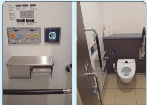
손이 쉽게 닿는 위치에 있는 알기 쉬운 세정버튼 및 각종 편의설비를 비치
