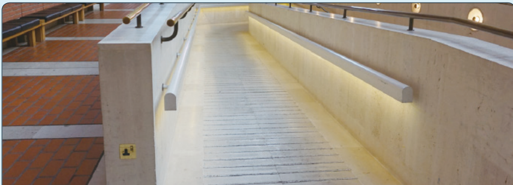
2단 손잡이와 조명, 미끄럼방지 처리한 바닥면의 경사로
