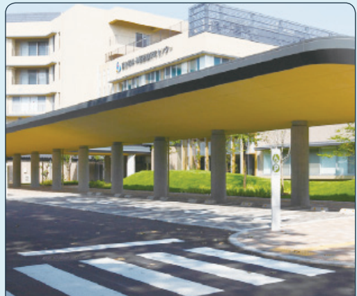
주차구역 상부에 눈, 비로부터 보호되는 지붕 설치
