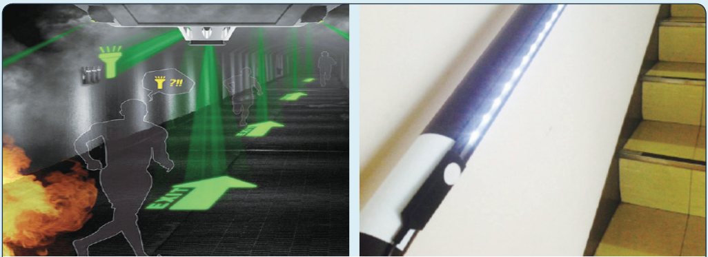
비상시 대피를 위해 유도용 비상 조명을 설치한 복도 및 계단 손잡이
