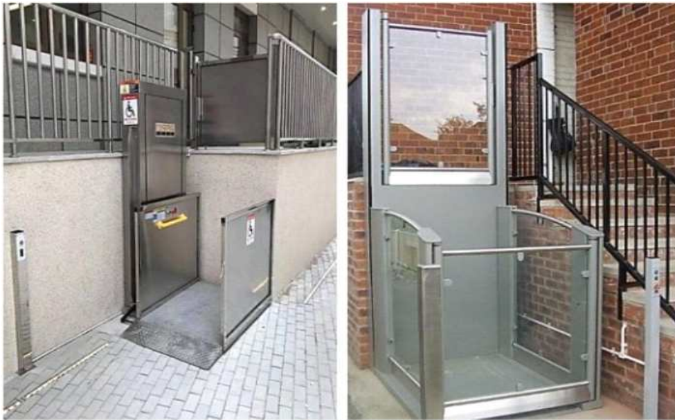
수직형 리프트 설치 모습
