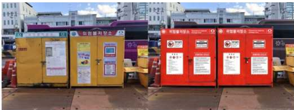
▲ 빨강색 바탕과 흰색 정보표시로 시인성을 높인 위험물 저장소(개선 전/후 개선 후)
