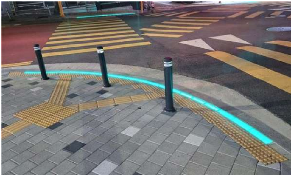
바닥형 보행신호등이 설치된 횡단보도
