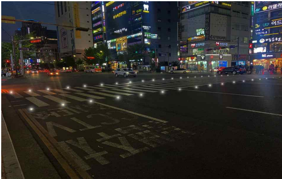
울산 남부보건소 앞에 설치된 발광형 도로표지병
