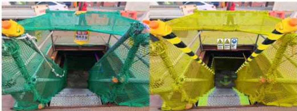
▲ 사고가 빈번한 출입구 및 수직동선의 주의를 강조하는 작업장 출입구 및 계단(개선 전/후 개선 후)
