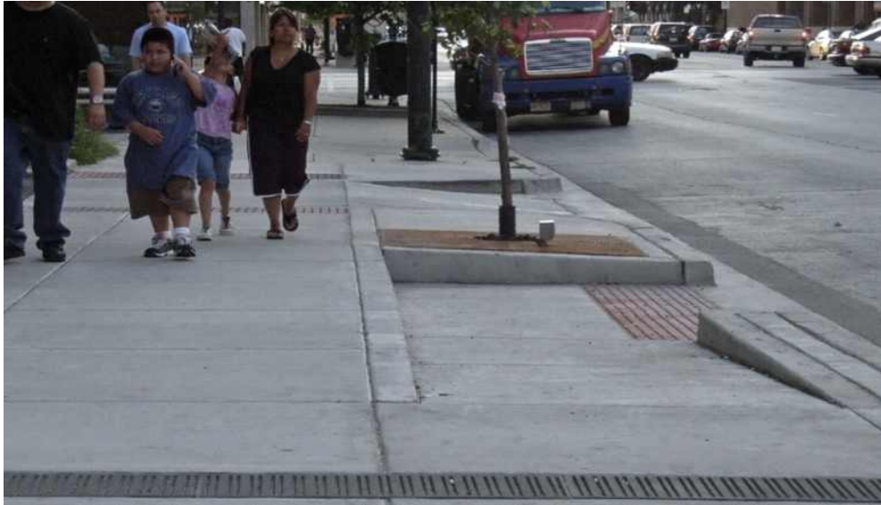
시카고의 Sidewalk Ramp
