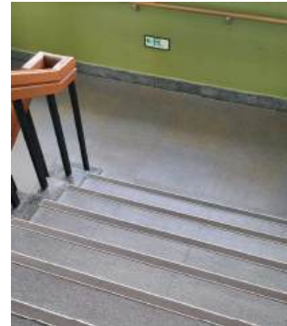
그림 17 계단 끝 점형블록 미설치
