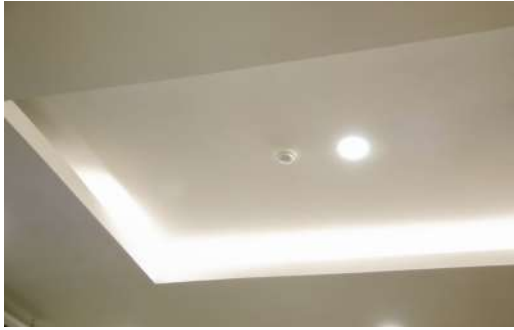
우물천장 설치 예시
