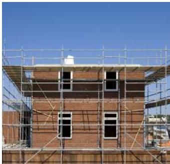
강관 비계(Steel Pipe Scaffold)
