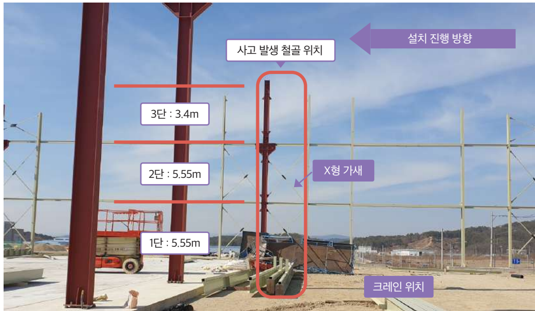
사고 현장 철골 설치 상황
