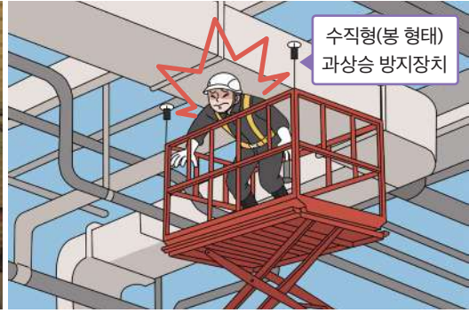
고소작업대 끼임 사고 모습
