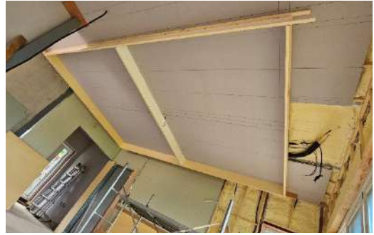
재해 당시 우물천장 시공
