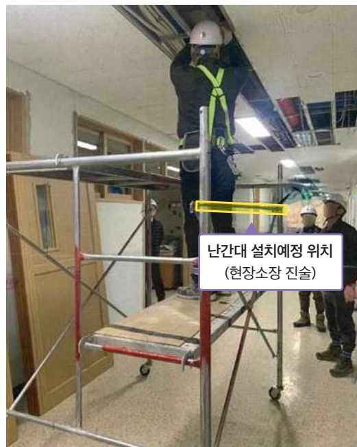
설치했어야 하는 안전난간 위치
