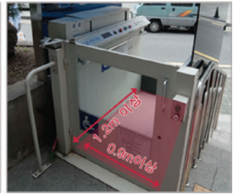
바닥이 폭 0.9m이상, 깊이 1.2m이상인 수직형 휠체어리프트를 설치한 사례 사진
