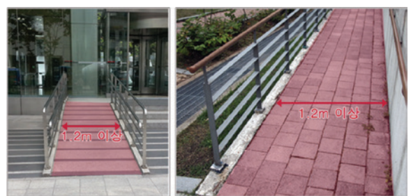
경사로의 유효폭이 1.2m이상으로 설치된 사례 사진
