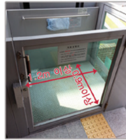
바닥이 폭 0.9m이상, 깊이 1.2m이상인 수직형 휠체어리프트를 설치한 사례 사진
