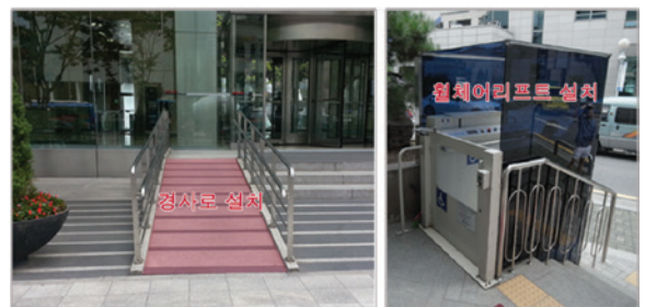
주출입구에 경사로 혹은 휠체어리프트가 설치된 사례 사진
