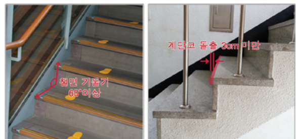
철크의 기울기와 계단코의 돌출길이를 규정에 맞게 설치한 사례 사진
