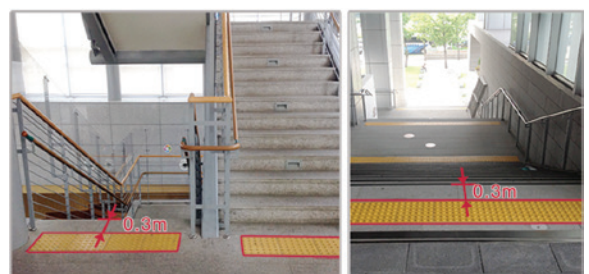
계단의 시작과 끝지점에 점형블록을 규정에 맞게 설치한 사례 사진
