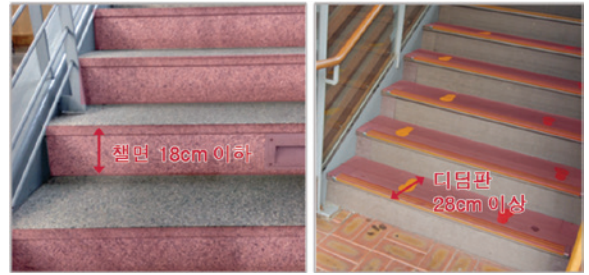
계단의 디딤판과 철크를 규정에 맞게 설치한 사례 사진
