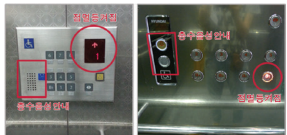
층수버튼을 누르면 점멸등이 켜짐과 동시에 층수음성안내를 설치한 사례 사진
