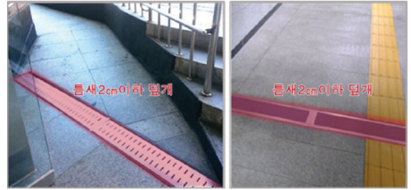
접근로 보도의 빠질 위험이 있는 곳에 틈새 2cm이하의 덮개를 설치한 사진
