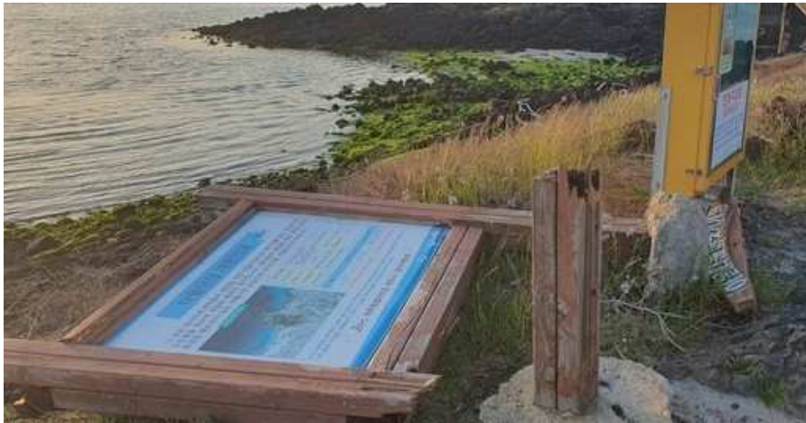
설치 후 방치된 연안 안내판 — 판면 훼손 · 지지대 부식 · 판독 불가
