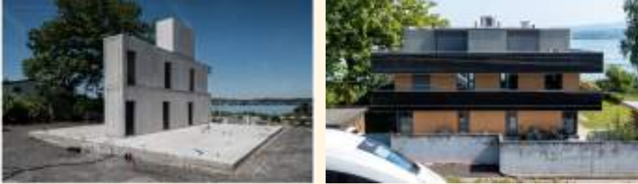
취리히 호숫가 프라이엔바흐 Freienbach 플러스에너지하우스. 지하층 및 계단실 콘크리트 구조공사가 끝난 후 일주일만에 목조건축으로 상층부 구조가 완성 8)
