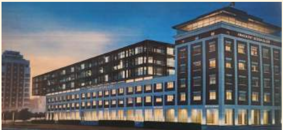
'레 도크스(Les Dock's)' 전방. 기존 항만장의 곡물 창고로 쓰였던 빨간 벽돌 건물 위에 금속으로 된 현대식 구조물을 새롭게 추가하여 개조하였다. ©조지 하인츠 제공
