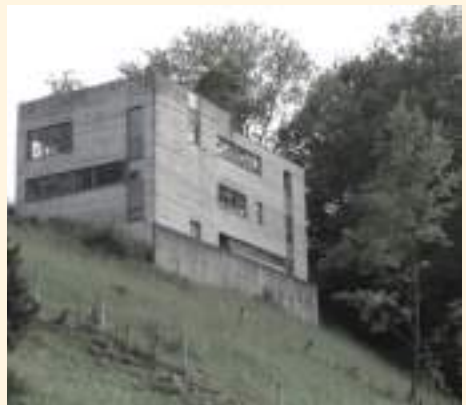
취리히 호숫가 빌렌 Wilen 플러스에너지하우스 단열재보강, 창문교체, 외장재 교체 등 외관만 보수공사. 공기펌프식 난방, 태양전지는 남향에 맞춰 지붕에 설치 6)
