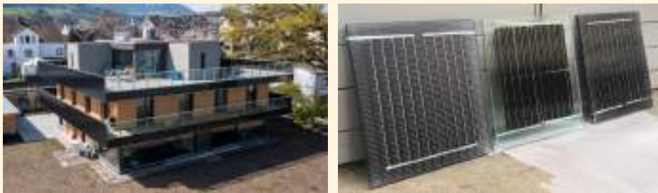
취리히 호숫가 프라이엔바흐 플러스에너지하우스. 기찻길 옆 소음방지를 위한 난간설치법규를 태양전지일체형 디자인 난간으로 설계하면서 자재업체와 공동 연구 9)
