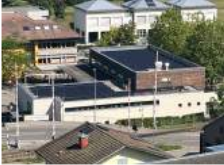
공공건축물 초등학교 지붕에 설치된 태양전지 ©박운정
