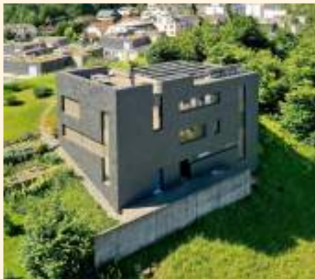
취리히 호숫가 빌렌 Wilen 플러스에너지하우스 단열재보강, 창문교체, 외장재 교체 등 외관만 보수공사. 공기펌프식 난방, 태양전지는 남향에 맞춰 지붕에 설치 6)
