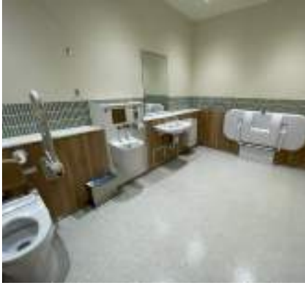
충분한 공간이 확보된 다목적화장실 ©이윤규
